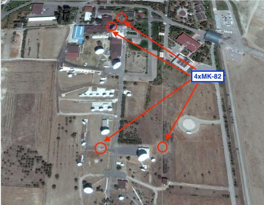
Şekil 62 TÜRKSAT Tesislerindeki dört patlamanın yerleri
