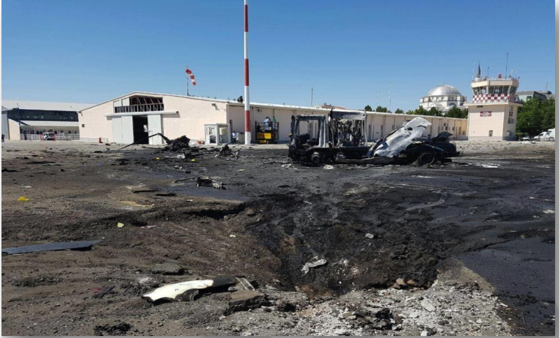
Şekil 44 Patlamanın helikopter pistinde yol açtığı hasar
