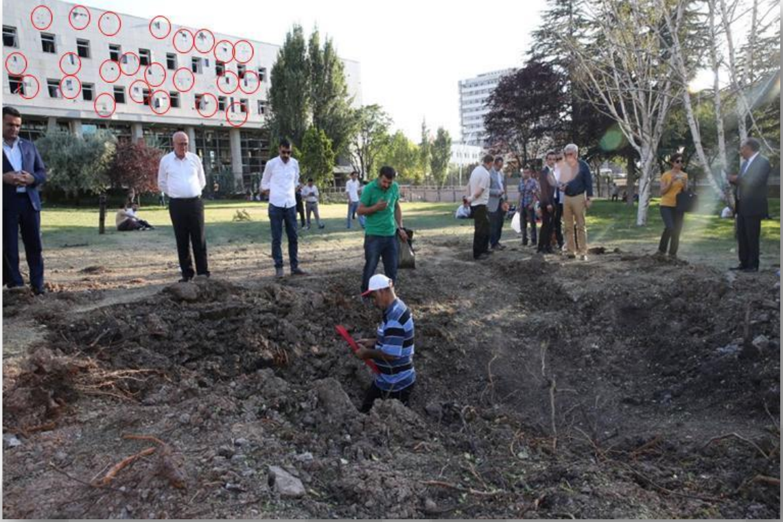
Şekil 28 Bombanın açtığı krater ve arkadaki bina üzerindeki muhtemel parça tesiri izleri
