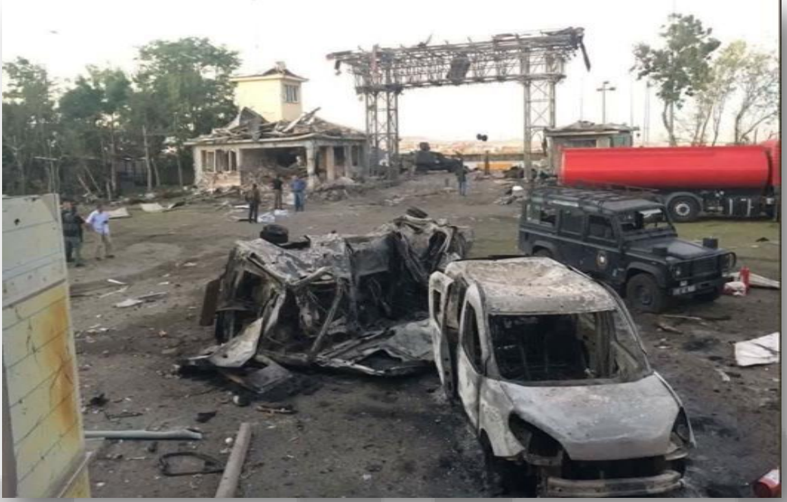
Şekil 46 Patlama sonucu meydana gelen hasar
