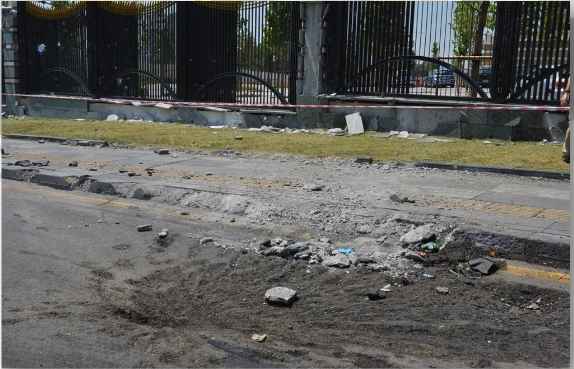
Şekil 42 Millet Camisinin önündeki yolda bulunan müdahale unsurlarına atılan ikinci bombanın yol açtığı tahribat
