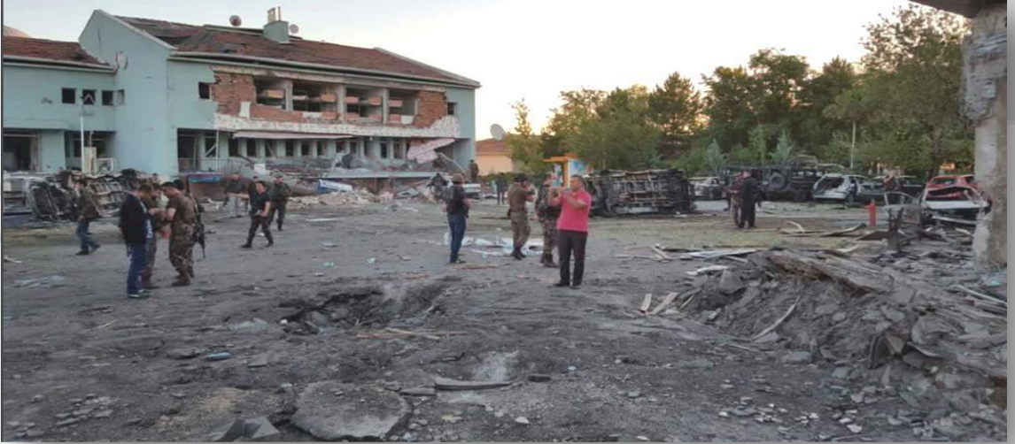
Şekil 47 Patlama sonucu meydana gelen hasar
